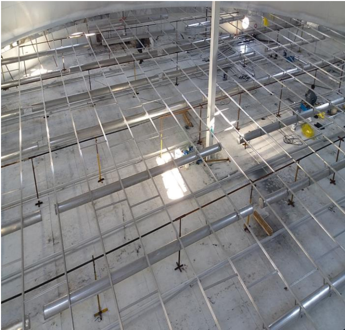
شاسی کشی و نصب پرلین های سقف شناور داخلی
