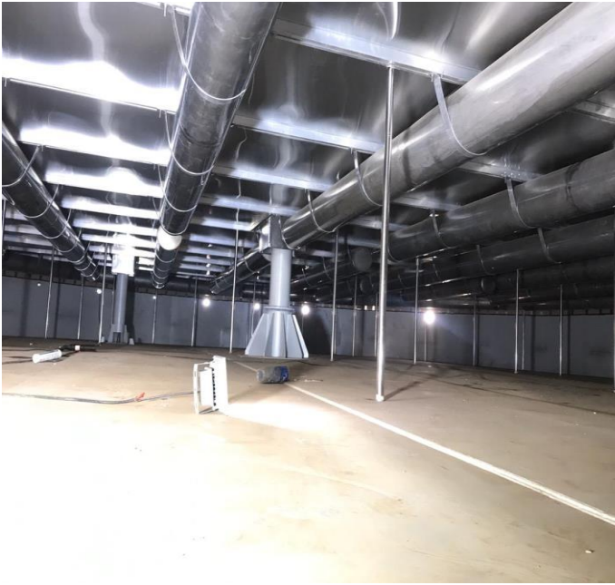
نصب نهایی پانتون های سقف شناور داخلی
